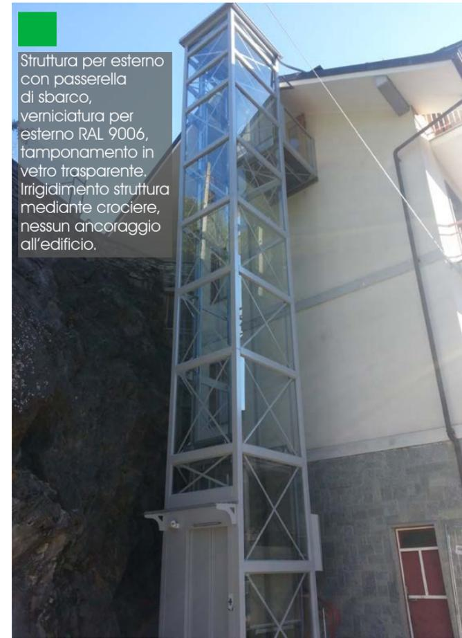
Struttura per esterno con passerella di sbarco, verniciatura per esterno RAL 9006, tamponamento in vetro trasparente. Irrigidimento struttura mediante crociere, nessun ancoraggio all'edificio.
